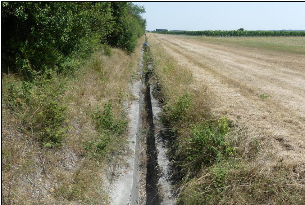
Figure 8 : Photographie du fossé bétonné
